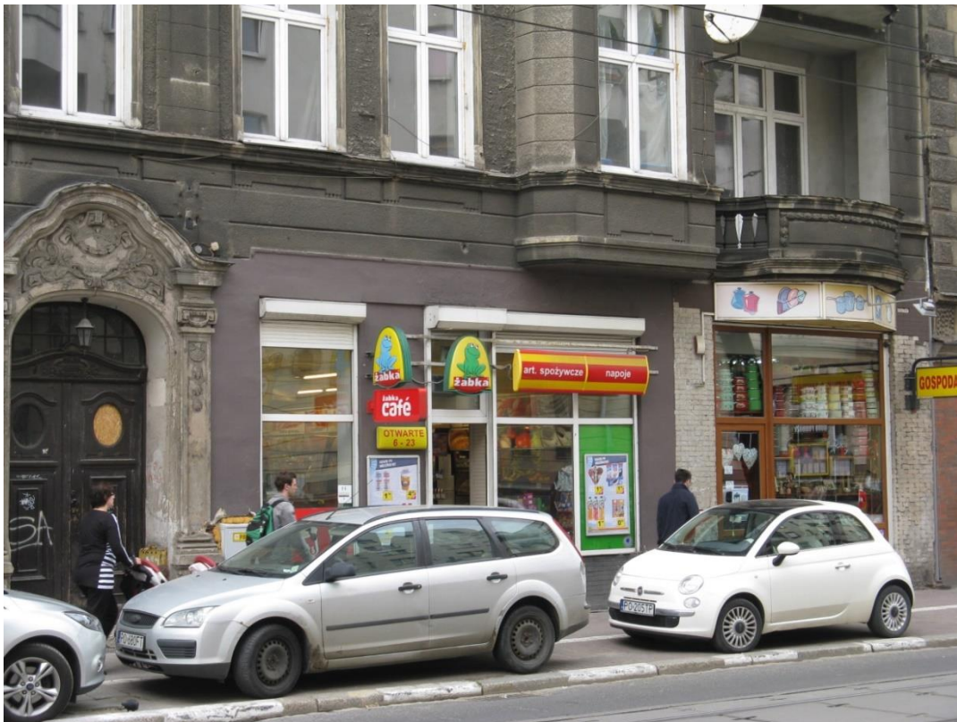
Fot.6 Parter kamienicy mieszczący lokale sklepowe, poza portalem nie zachowany detal parteru
