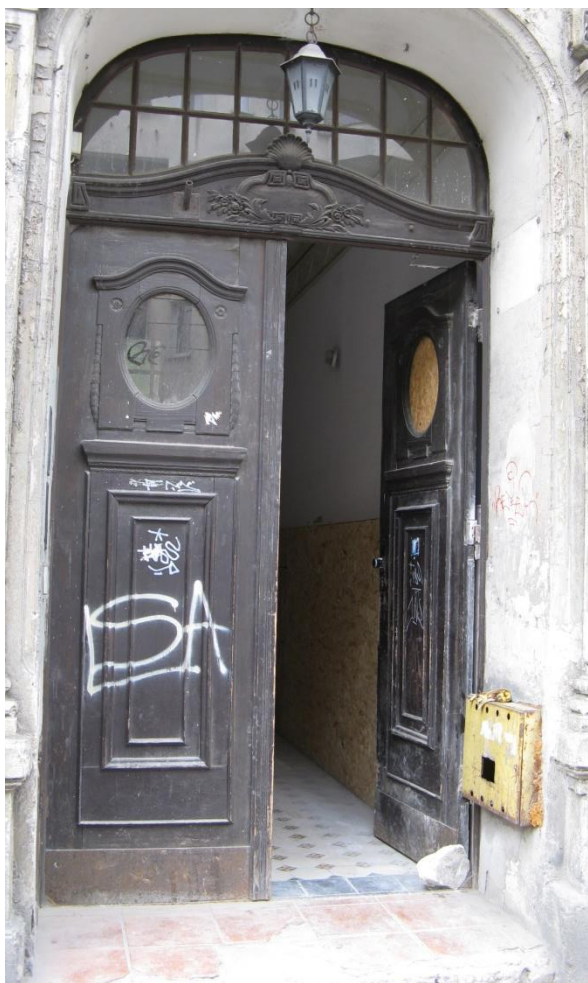
Fot. 13 Drzwi wejściowe – pierwotna stolarka
