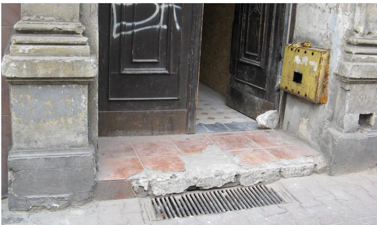
Fot. 14 Próg – wtórne obłożenie płytkami
