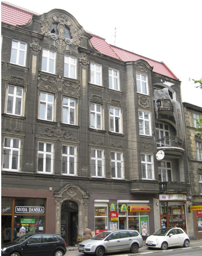
Fot. 3 i 4 Elewacja frontowa kamienicy
