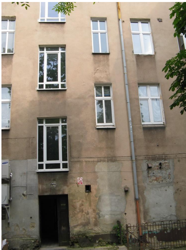
Fot. 15 Elewacja tylna – tynki gładkie, bez detalu sztukatorskiego, stolarka drzwiowa oryginalna
