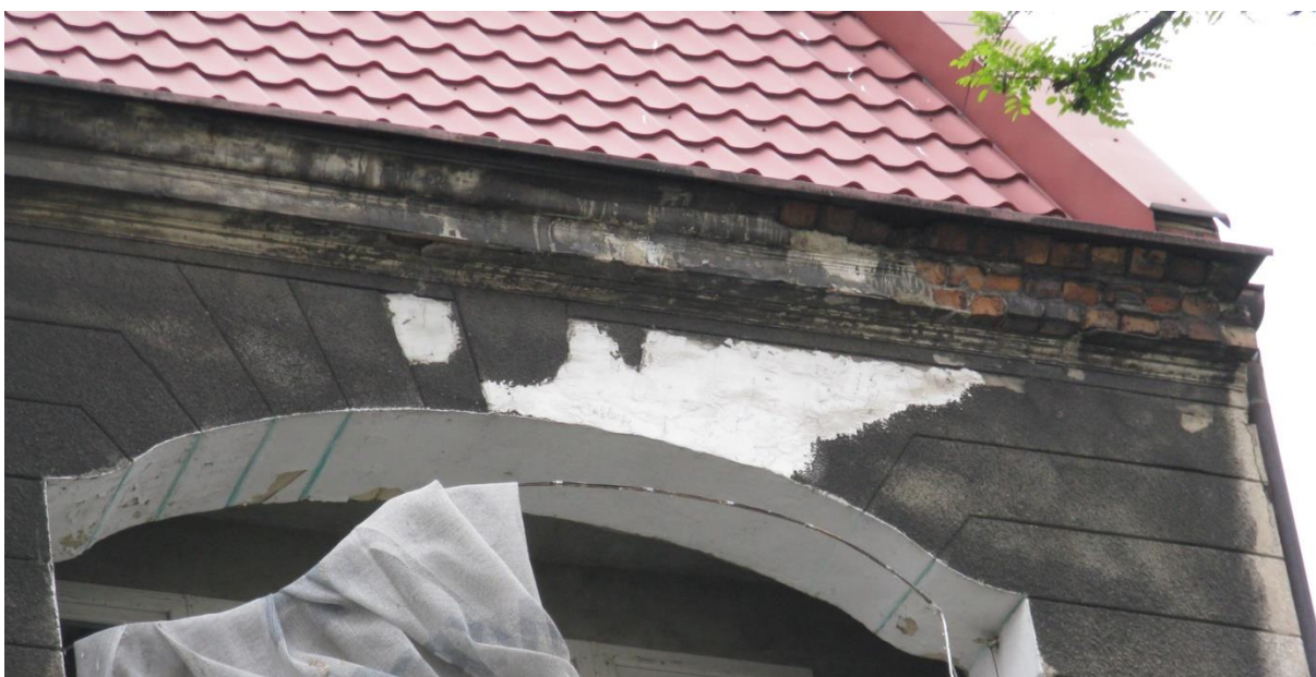
Fot. 10 Uszkodzenia gzymsu wieńczącego
