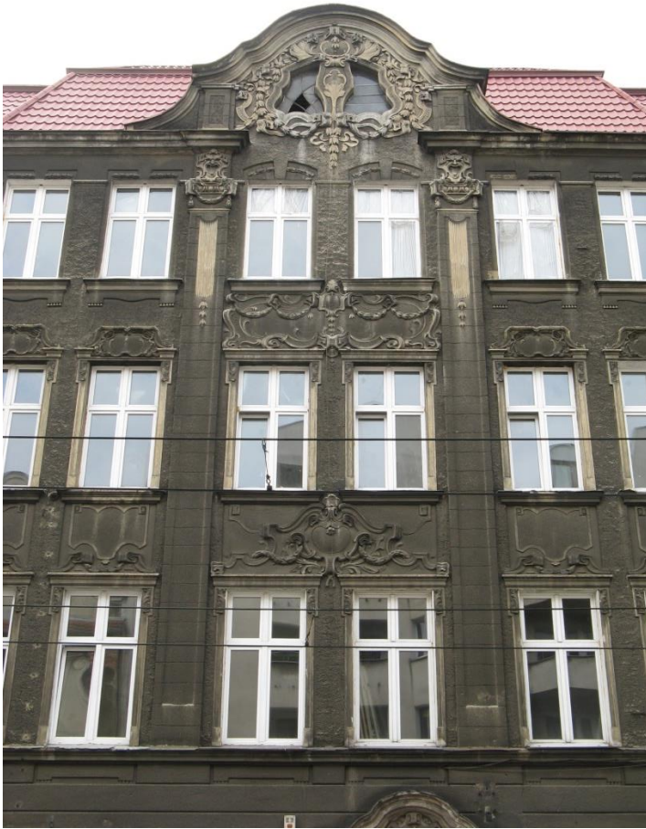
Fot. 1 Elewacja frontowa kamienicy ul. Kraszewskiego 11 (fragment centralny)
