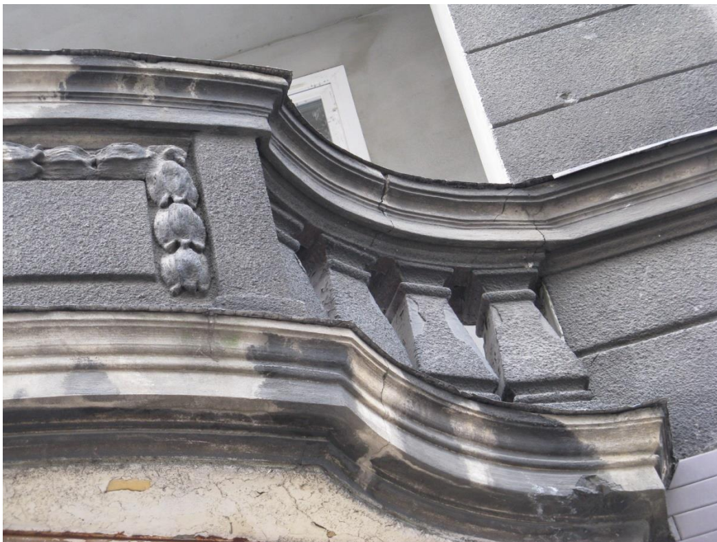
Fot.8 Fragment balkonu – na tralkach widoczne odspajanie się tynku nakrapianego, położonego wtórnie
